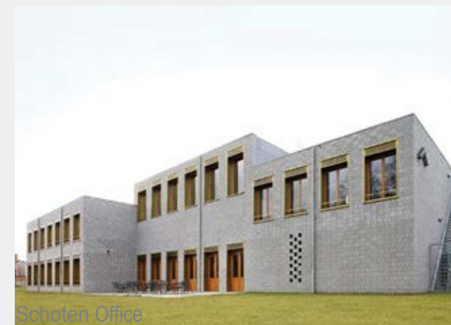
Schoten Office Architect: Bovenbouw / Dirk Somers
