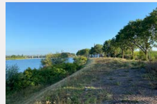
2. Uitzicht over Maas, Borgharenstuw en Zinkwitschoorsteen (m)
