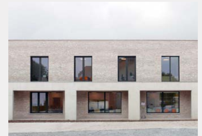
Kantoor Hamme Architect: Thys Vermeulen
