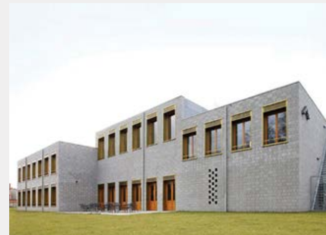
Kantoor Schoten Architect: Bovenbouw / Dirk Somers
