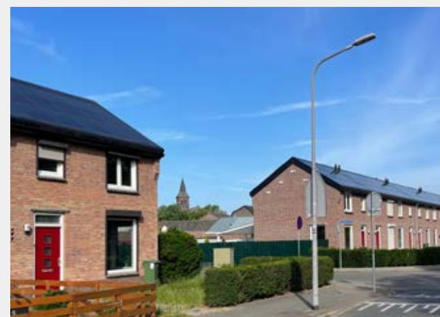
Geïntegreerde pv-panelen op zadeldaken
